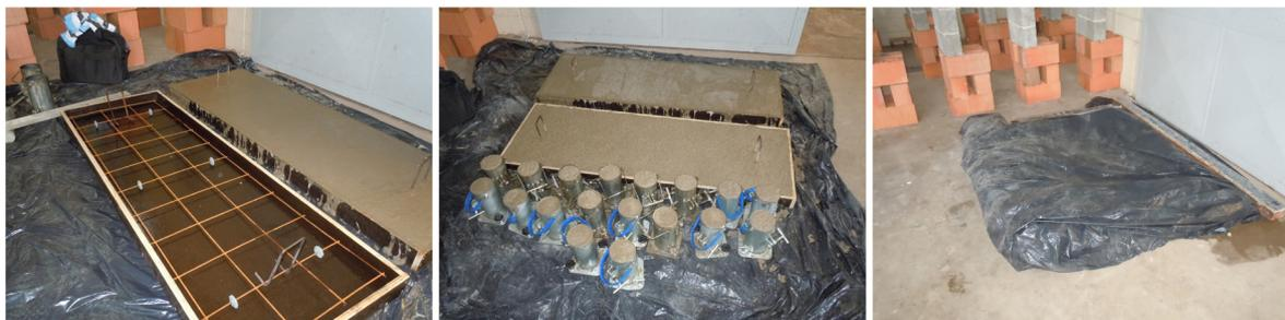
**Figura 1:** (a) Detalhe da forma, das (b) lajes concretadas juntamente com os corpos de prova e do (c) processo de cura sob lona plástica.
